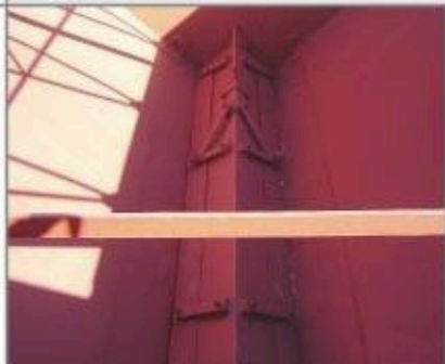
Riendas interiores de sustentación; enganches internos para elevación y guillotina de regulación.
